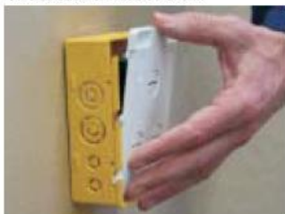
2) Vložení krabice KUH 1/L do připraveného otvoru. Uzavření krabice dnem.
