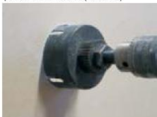
1) Vytvoření otvoru \varnothing 73,5 mm do sádrokartonu pomocí vrtáku VDS 68 (viz str. 42).
