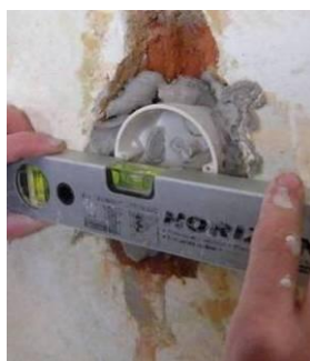
obr. 215 – kontrola otvorů pro uchycení přístrojů
