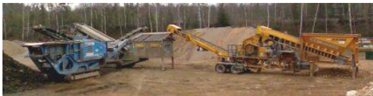
obr. 520 – mobilní recyklační linka na stavební odpad
