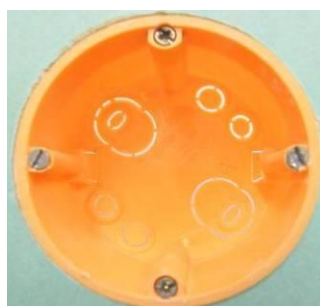
obr. 174 – osazení krabice do sádkartonu
