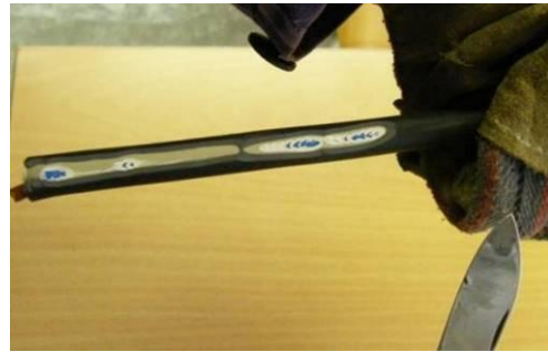
obr. 137 – seříznutí pláště kabelu
