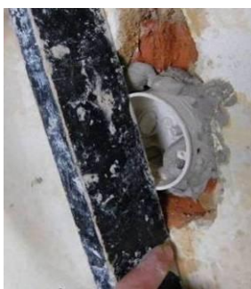
obr. 214 – kontrola krabice 2. směr
