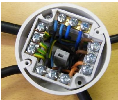
obr. 205 – zapojení krabice KR 68
