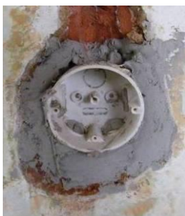
obr. 216 – doplnění sádrového pojiva
