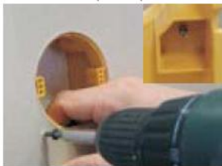
4) Upevnění krabice samořeznými vruty. Detail odděleného prostoru pro vrut.
