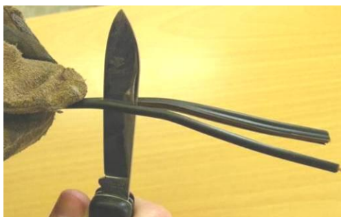
obr. 133 – rozříznutí pláště plochého vodiče
