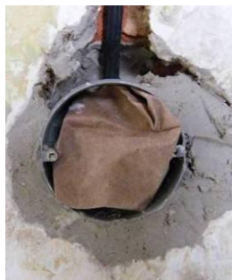
obr. 219 – ucpání krabice papírem
