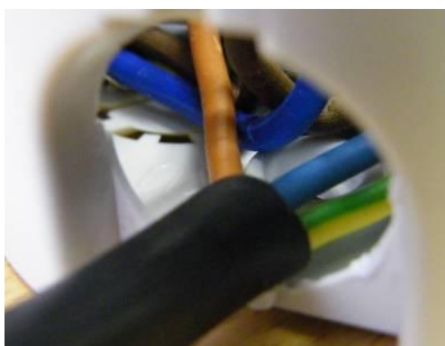
obr. 207 – detail ukončení kabelu v krabici
