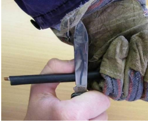
obr. 136 – nasazení nože na kabel CYKY
