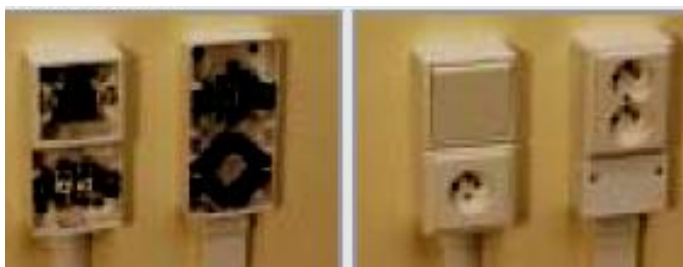
obr. 182 – ukázka montáže přístrojů do dvojité krabice
