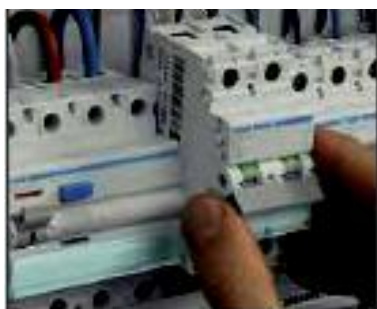
obr. 475 – montáž nebo demontáž přístroje v rozvaděči
