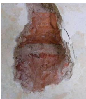
obr. 210 – vysekaná kapsa pro krabici
