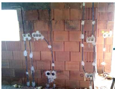
obr. 220 – ukázka sádrování krabic a trubek
