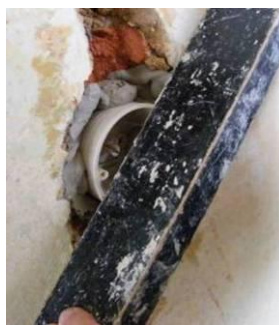
obr. 213 – osazení krabice a její srovnání 1. směrem
