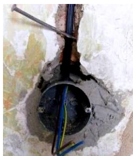
obr. 217 – položení a zajištění plochého vodiče
